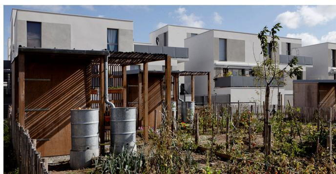
Récupération et stockage des eaux pluviales des toitures
