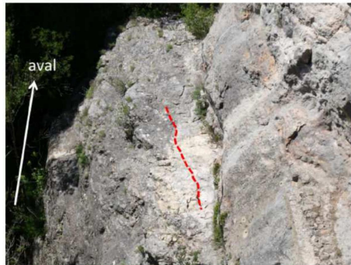
Détail de la zone affectée par la fracture parallèle à la Cause en rive droite à l'aval du barrage
