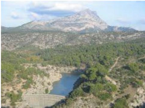
• **Le barrage de Bimont**, en amont de la commune, (réalisé entre 1946 et 1952 par l'ingénieur Joseph Rigaud pour l'alimentation en eau de la région d'Aix, avant la réalisation de l'infrastructure hydraulique du canal de Provence), est un ouvrage de type voûte, classé depuis 1973. Un parcours de randonnée le relie au lac Zola qui lui sert de réservoir tampon.
