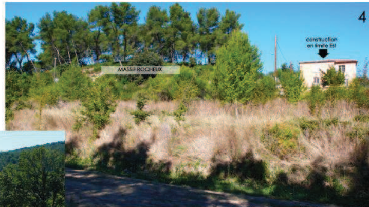
Vue depuis le chemin interne
